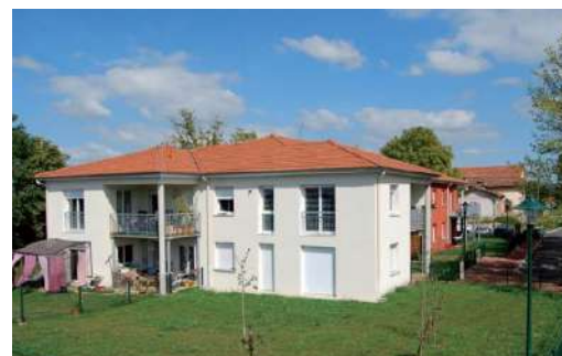
Habitat collectif – Boisset-les-Montrond (42)
