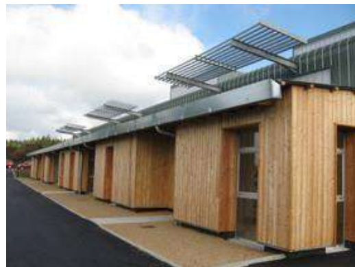
Locaux artisanaux – Saint Julien-Puy-Lavèze (63)
