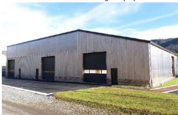
Locaux artisanaux – Vic-sur-Cère (15)
