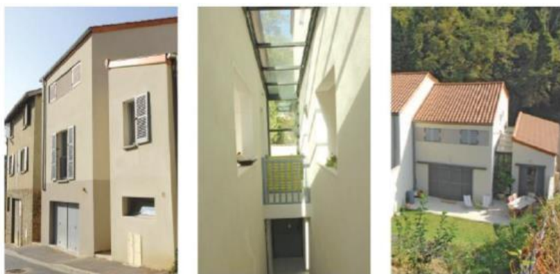
Exemples de logements de facture récente, épousant le dessin du parcellaire et respectant la volumétrie des anciennes maisons de ville, d'où l'implantation harmonieuse de ces logements par rapport à l'existant.
