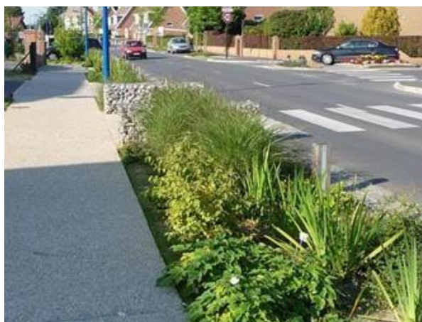
Piste cyclable sécurisée et passage piéton
