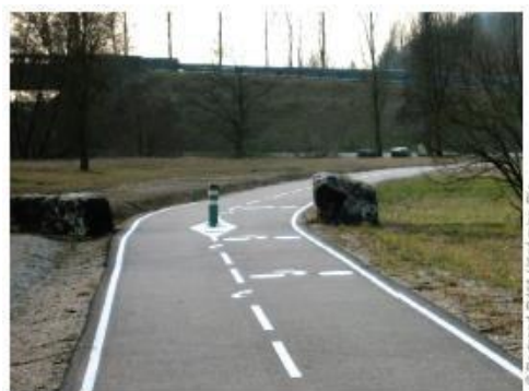
Le dispositif anti franchissement est intégré assez discrètement sans recours à des barrières
