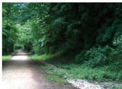
En rebord de piste une tranchée draine la falaise amont
