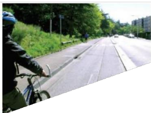
L'ajout de bordures permet de prendre de l'espace sur la voirie pour sécuriser le cycliste sans travaux importants
